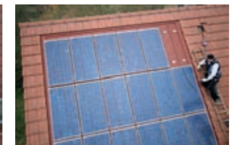
3. Le placement des modules
