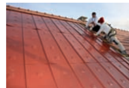
1. La pose des tôles de couverture
